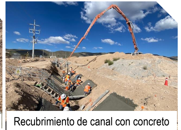
Recubrimiento de canal con concreto
