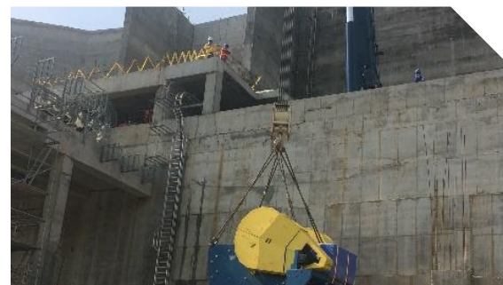
Montaje mecánico de triturador secundario
