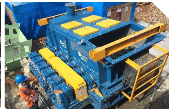
Montaje mecánico de alimentador
