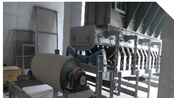
Montaje de banda transportadora y tolva receptora
