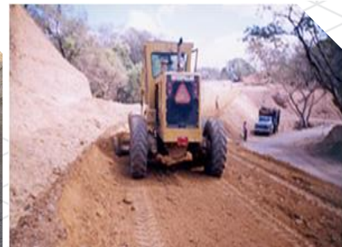
Tendido de capa base
