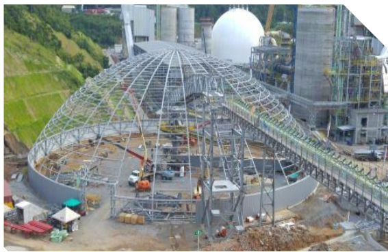
Montaje estructura domo circular
