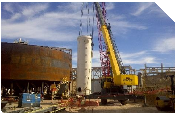
Montaje de tanque de fibra de vidrio
