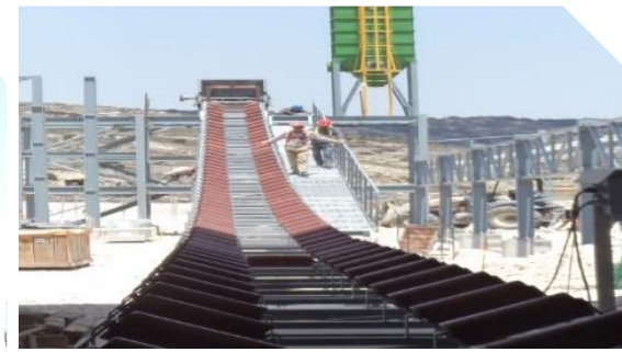
Montaje de banda transportadora de materia prima
