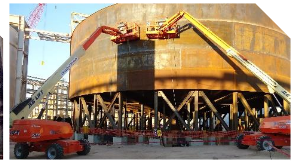
Montaje de tanque metálico Clarificador
