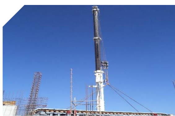
Montaje de alimentador de placas
