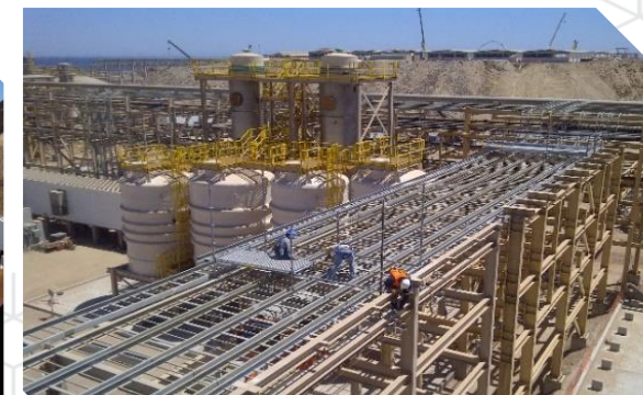
Instalación de charola eléctrica
