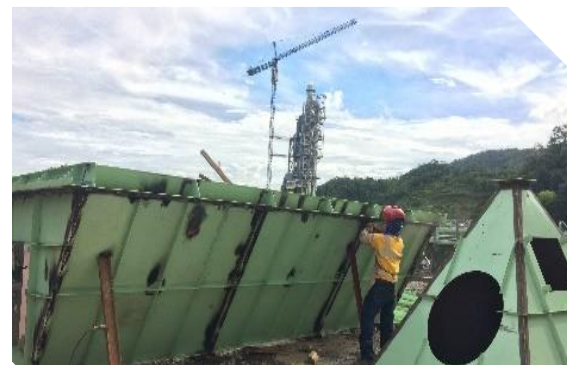
Armado de tolvas de recepción
