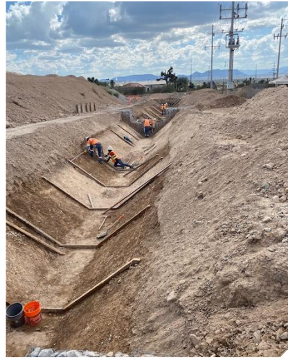
Construcción de canal
