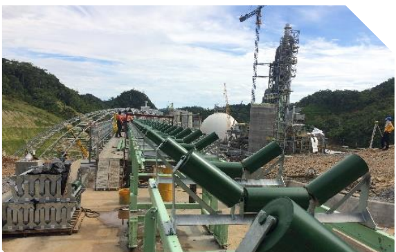
Montaje de banda transportadora
