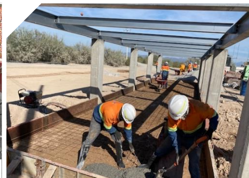
Piso de concreto hidráulico
