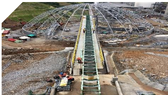
Montaje de banda transportadora y almacén circular
