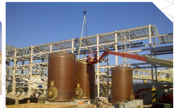
Montaje de tanques de fibra de vidrio.
