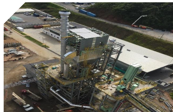
Montaje edificio molino coque
