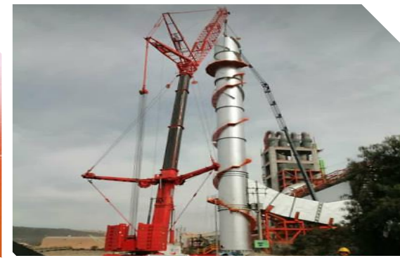
Montaje de chimenea
