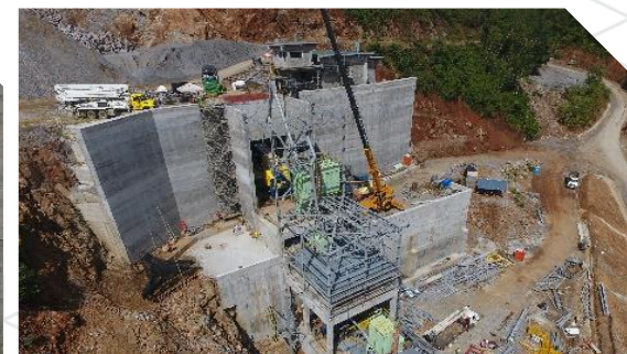
Montaje estructural y mecánico edificio de trituración.
