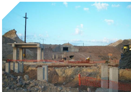
Excavaciones y cimentaciones
