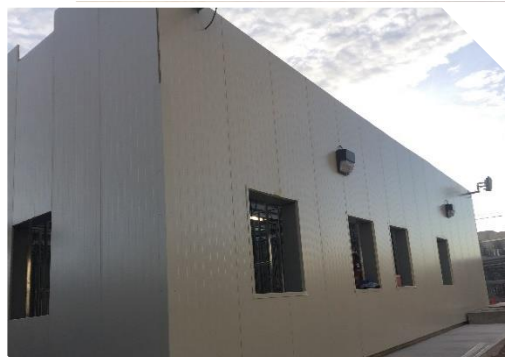
Construcción de oficinas
