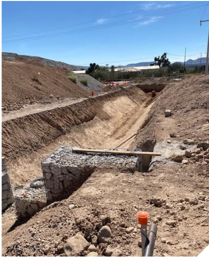
Construcciones de gaviones
