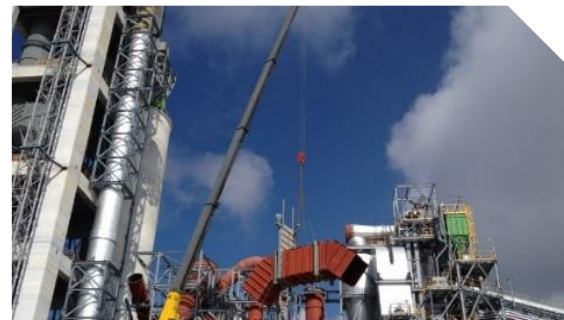
Montaje de ductos de intercambiador de calor
