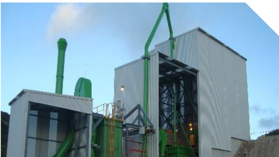
Instalación de lamina y ductos en trituración
