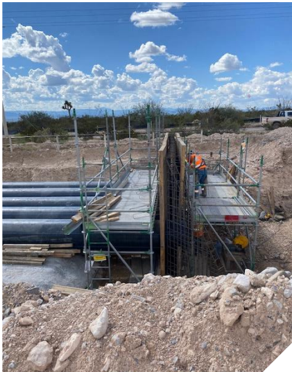
Alcantarilla 1 para paso de drenaje pluvial
