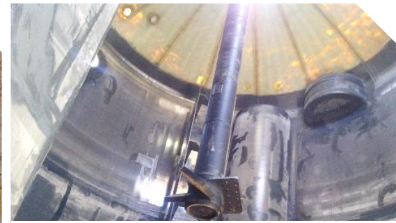
Montaje de agitador en tanques de fibra de vidrio
