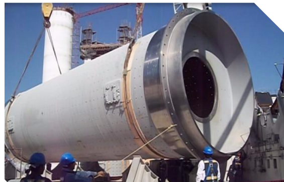
Montaje de molino de cemento
