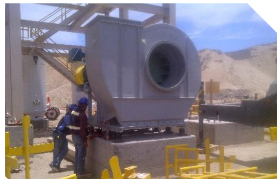
Montaje mecánico de ventilador
