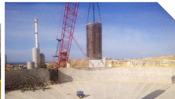
Montaje de columna central de espesador
