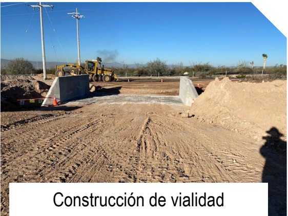
Excavación para alcantarilla 2
