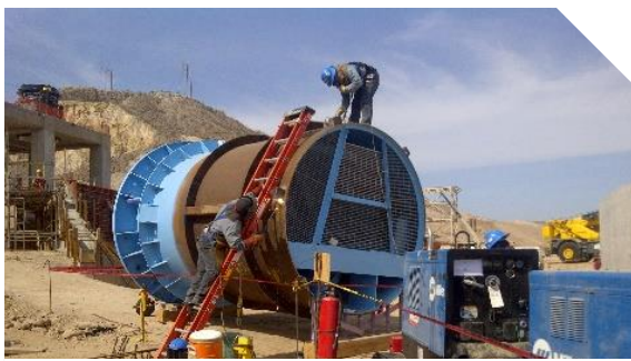
Montaje equipo mecánico espesadores
