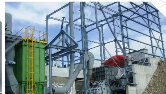
Montaje de estructura metálica edificio de trituración
