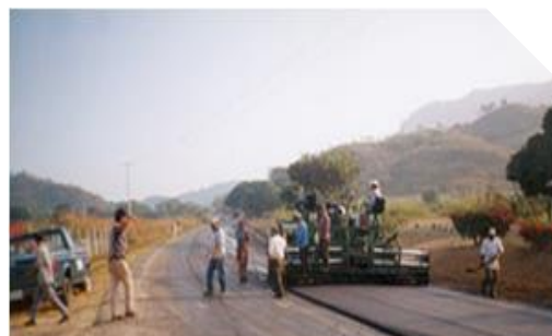
Construcción de pavimento asfáltico
