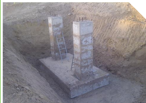
Construcción de cimentación
