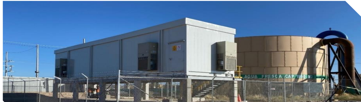
Montaje de cuarto eléctrico
