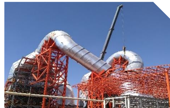
Montaje de ductos
