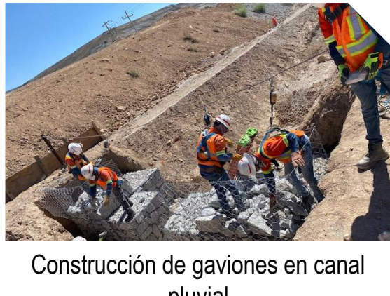
Construcción de gaviones
