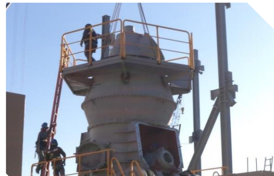
Montaje de molino de coque
