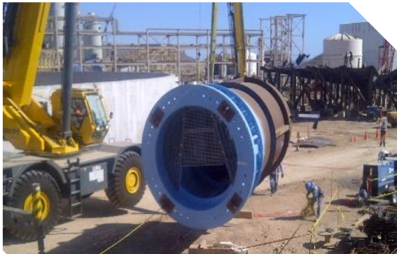
Mecanismo de giro del espesador
