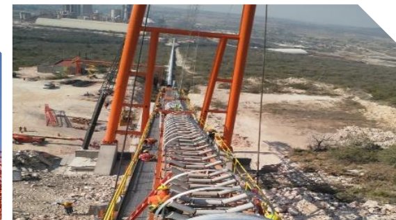
Montaje banda transportadora (banda kilométrica)
