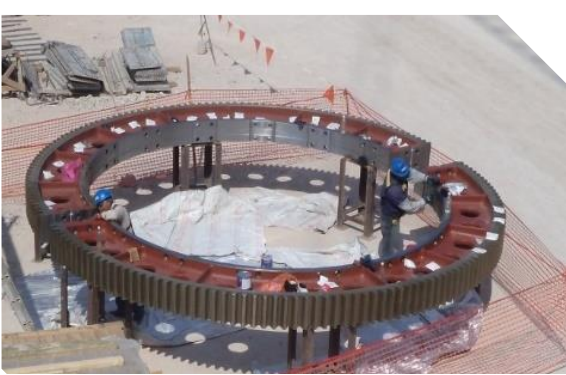
Montaje mecanismo del horno
