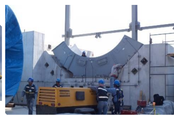
Montaje bases del molino
