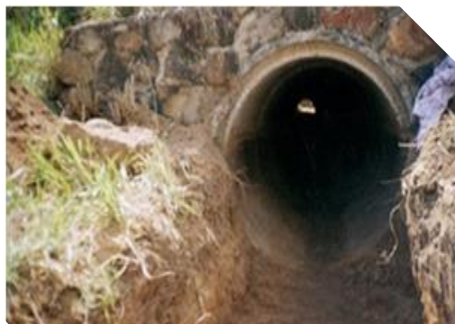
Obra de drenaje en caminos
