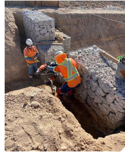
Construcciones de gaviones
