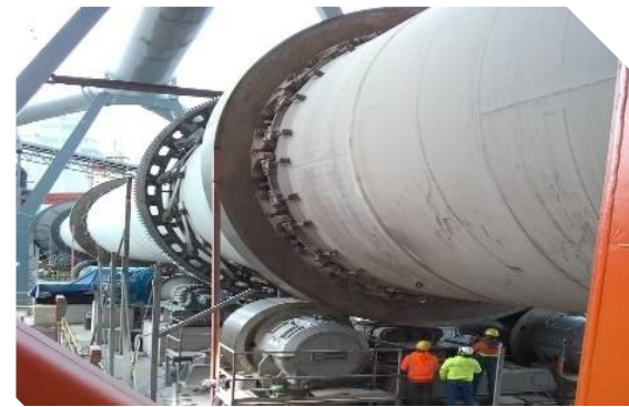
Nivelación y alineación del Horno 2
