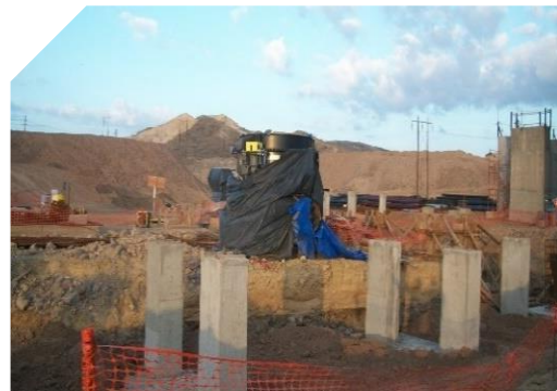
Bases de concreto
