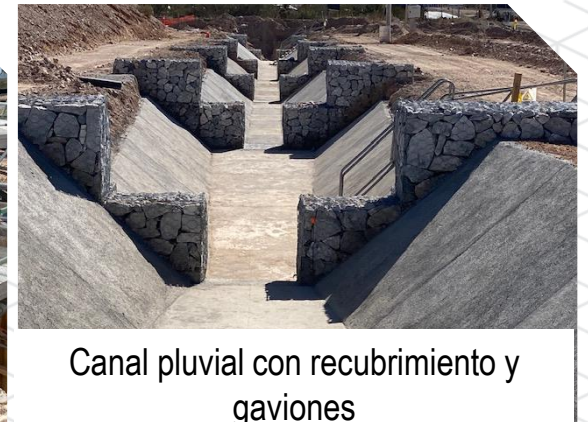
Construcción de gaviones
