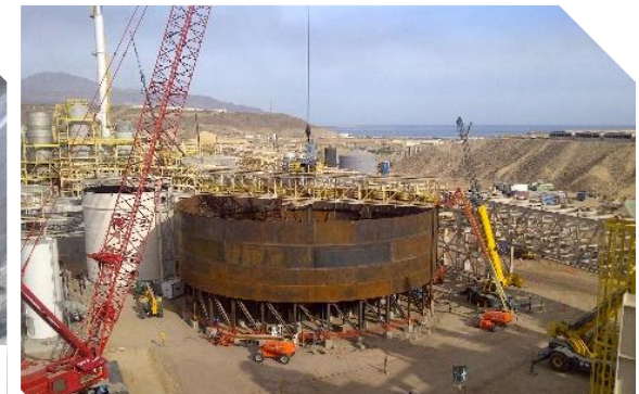
Montaje de clarificador
