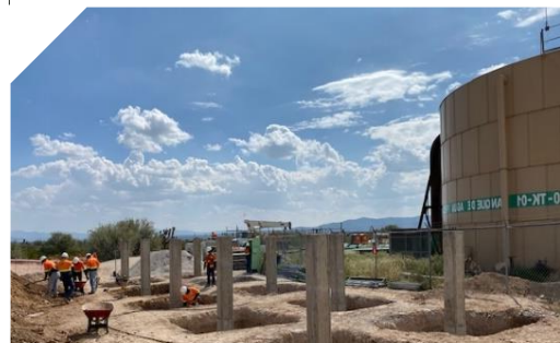
Construcción columnas de concreto
