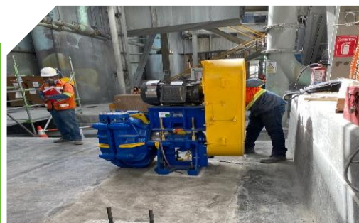
Bases de concreto para Equipo Mecánico
