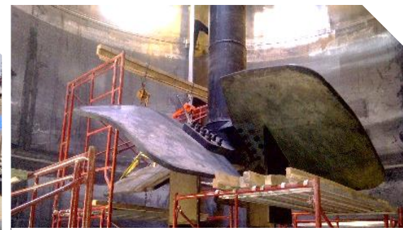
Aspas de la columna central del agitador
