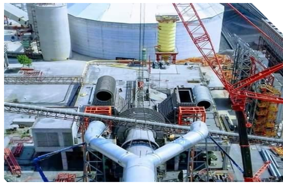
Montaje ducto, aire terciario
