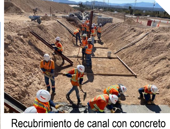
Recubrimiento de canal con concreto
