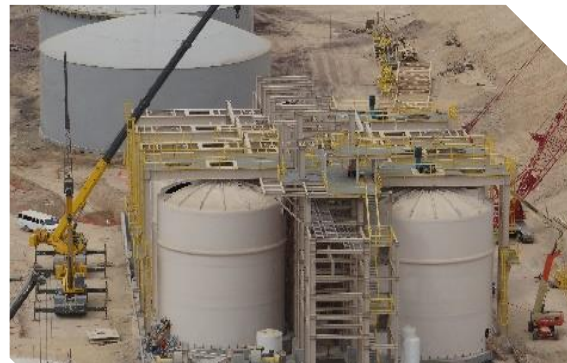
Montaje de tanques de fibra de vidrio
