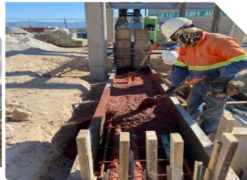
Vaciado concreto en trincheras
